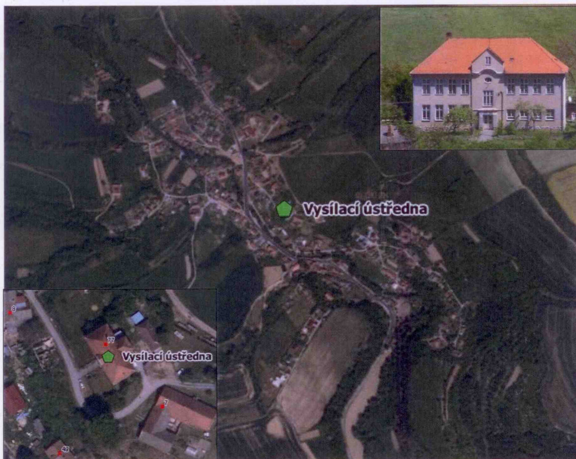
Umístění vysílací ústředny v budově úřadu obce.
